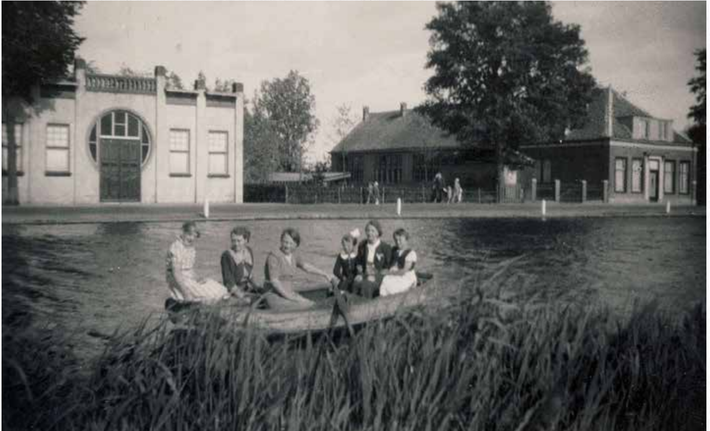
Links het gebouw van Zoetemelk meer in detail.
